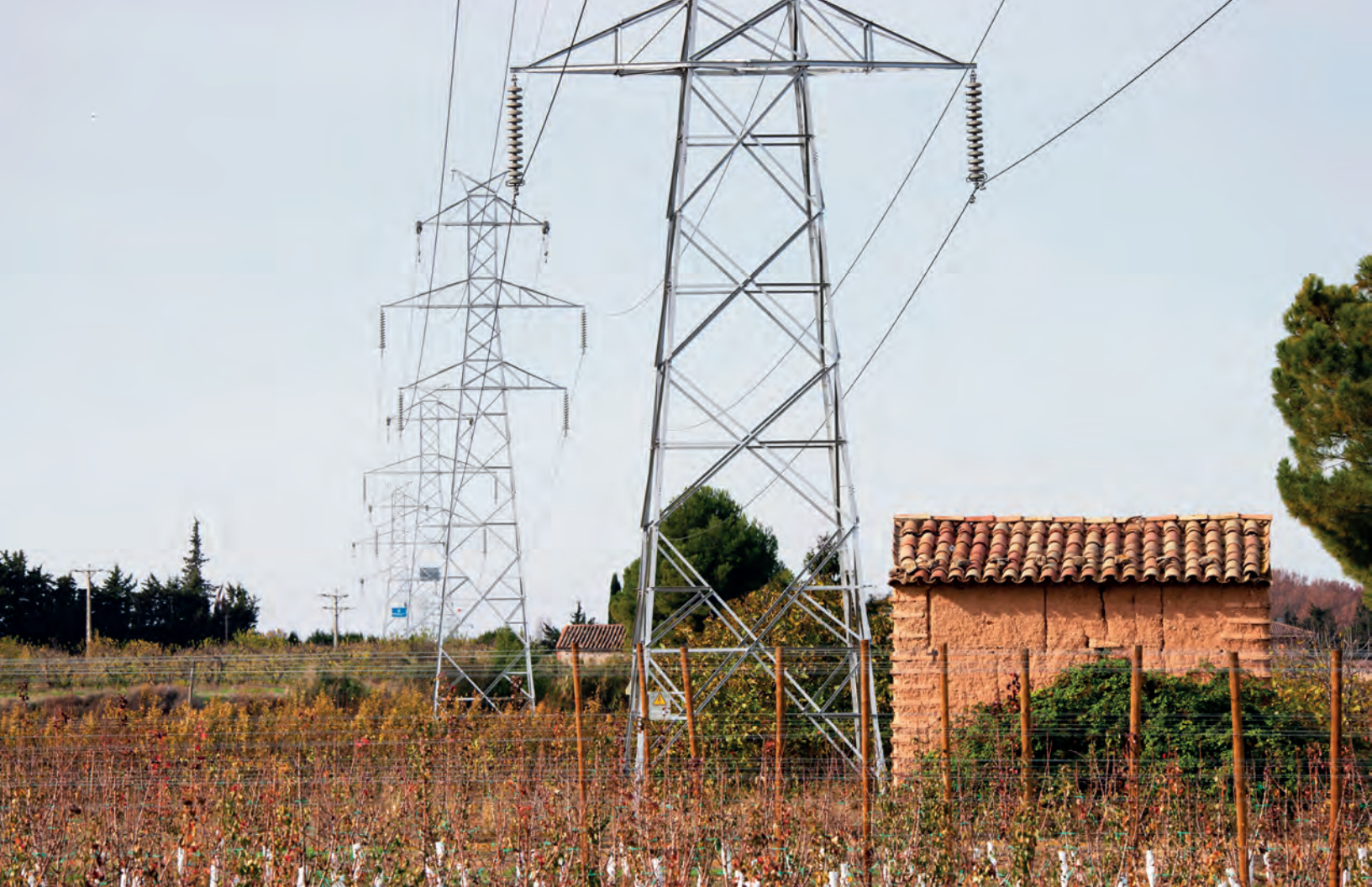
◆ Línia d'alta tensió de Red Eléctrica Española al pas pel nord de les Garrigues. FOTO: Xavi Minguella
