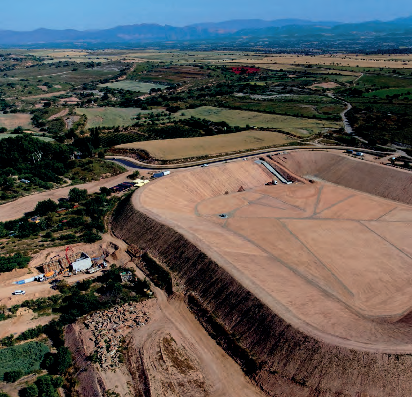
◆ Una bassa amb capacitat per a 450.000 metres cúbics d'aigua que el govern espanyol està construint a Castellserà.
